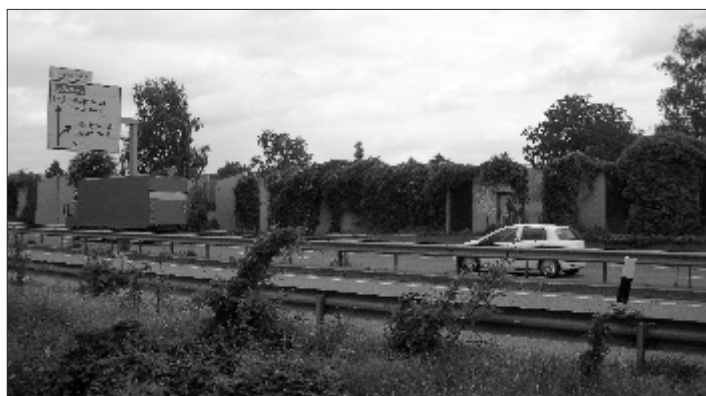
Lärmschutzwand für ein Wohngebiet entlang einer vierspurigen Bundesstraße Foto: Kurt Witterstätter
